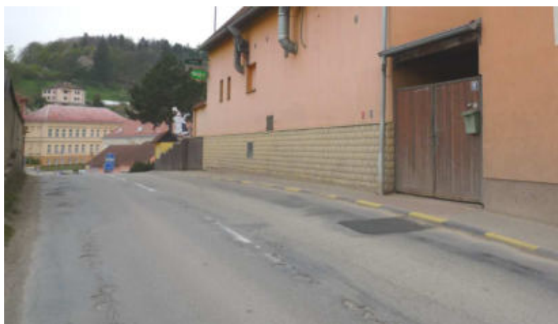
Obr. 2 Na stávající nepříznivé hlukové situaci se podílí i stav povrchu sil. II/373
